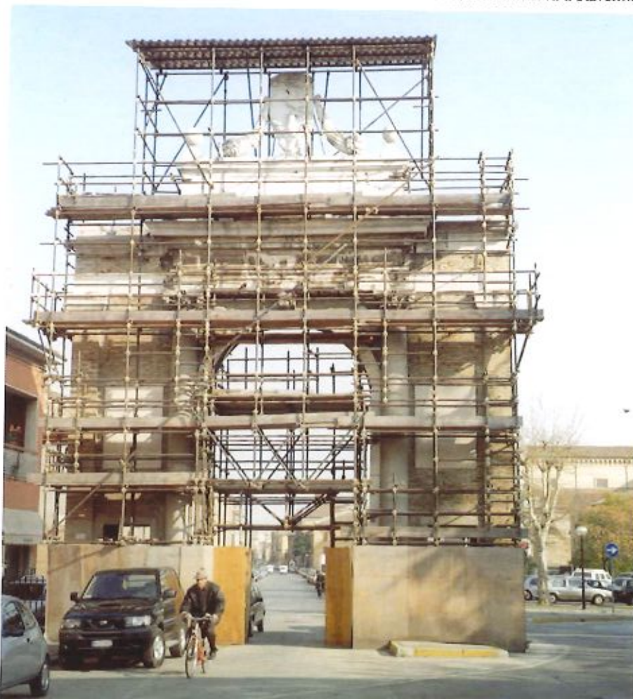
Cantiere di restauro della Porta Nuova a Ravenna.
