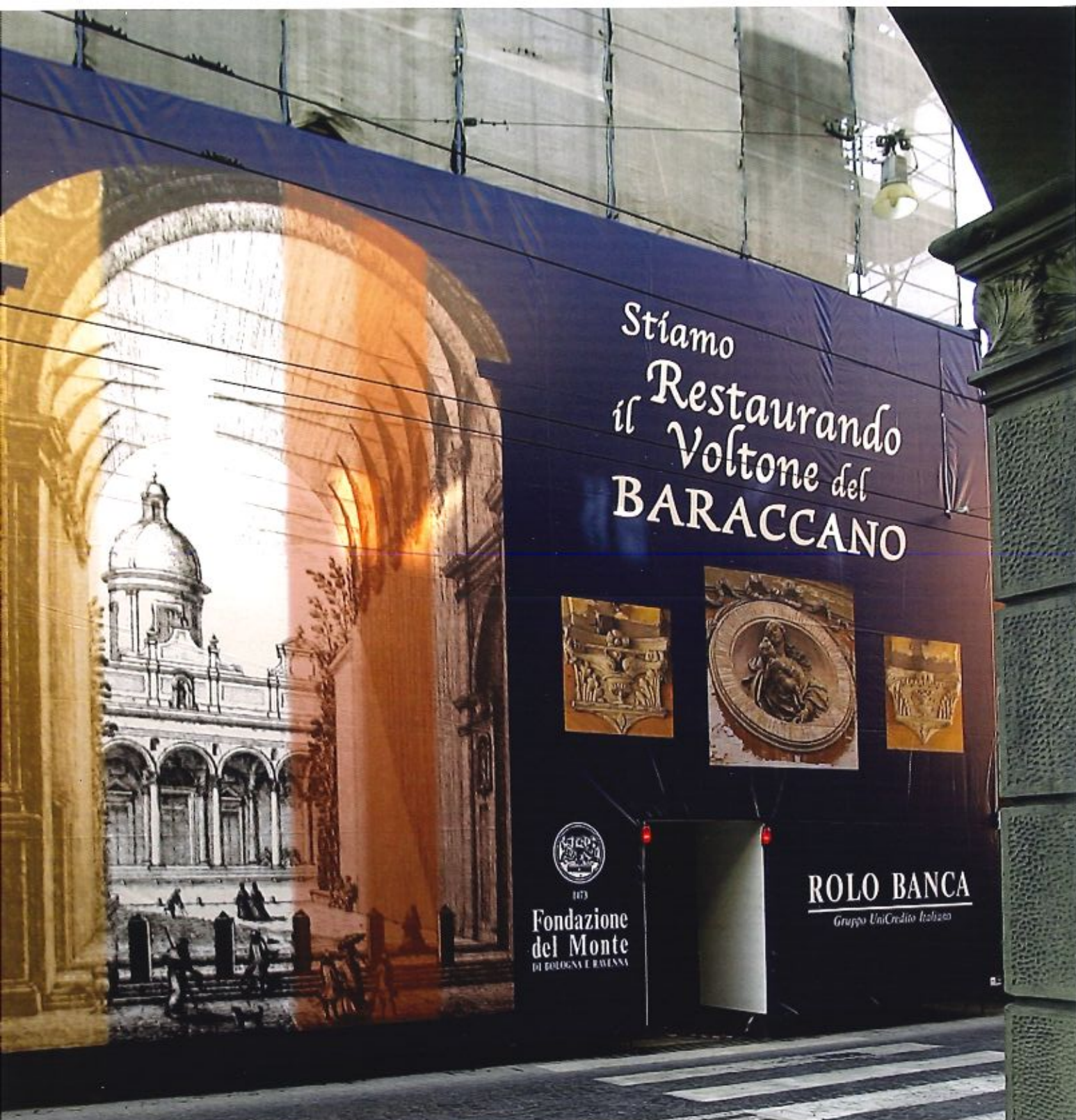
Cantiere di restauro promosso dalla Fondazione.
